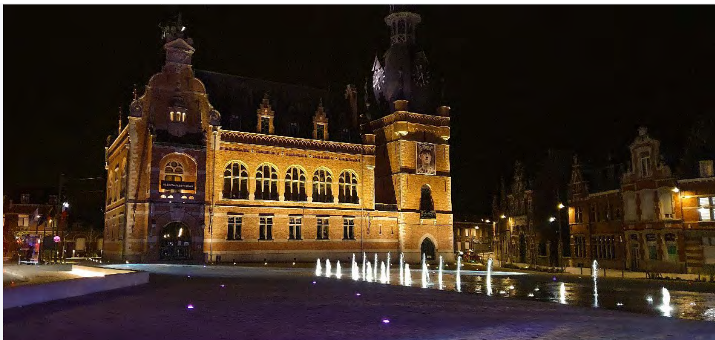
Grand-place et hôtel de Ville de Comines, France – Mise en valeur, éclairage architectural © Candéliance – 2020
