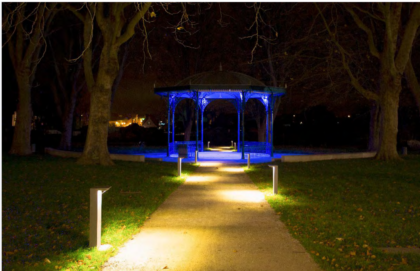
Jardin du cœur de Comines, France - Mise en valeur, éclairage architectural © Candéliance - 2020
