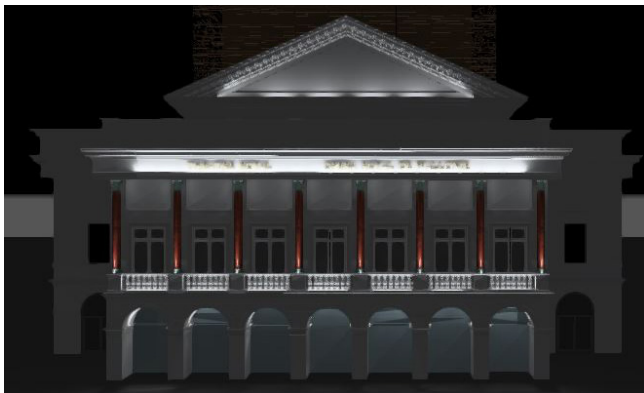
Une simulation de rendu permet de faire une première approche sur la teinte qui sera utilisée selon l'effet recherché.
