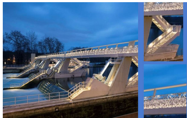
258 School-light ref 5640 en 3000K et L6 (116x44 déviée de 36) assurent la sécurité des usagers et le respect des normes PMR
