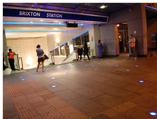
42 balises 2855-Meteor à LED bleues orientées à 120°
