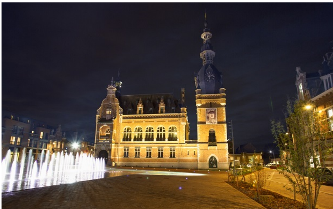
La Grand Place et l'Hotel de Ville de Comines sont éclairés par des encastrés de sol Allevard ref 5716 (façades) et Pyramide ref 2852H (parvis)
