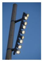
Les 45 projecteurs à LED orientables LEC Luminy 4 – 4040, équipés chacun de jeux d'optiques adaptés, permettent d'obtenir un éclairement de ces formes parfaitement homogène au sol. LEC a conçu 3 groupes indépendants de projecteurs sur chacun des mâts :
