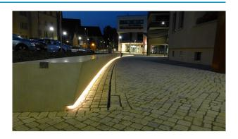
58,5 mètres linéaires (27 de 2m + 2 de 1.05m + 1 de 0.70m + 1 de 1.65m + 1 de 0.40m) de 5620-PE80 Brunei sont encastrés au banc.
