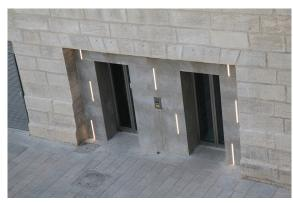
8 linéaires à LED encastrés au mur, à lumière homogène 5623-Brunei en blanc neutre, de longueurs customisées (2 de 42 cm, 4 de 52 cm et 2 de 51 cm) signalent les portes d'ascenseurs.
