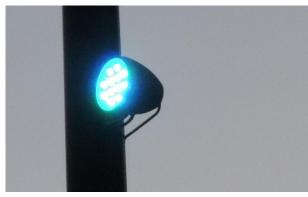
Fixés sur des mâts, 6 projecteurs 4040-Luminy 4 de 12 LEDs (5 en vertes, 7 en bleues) à optiques quasi-dédiées à chaque emplacement (10°, 20°, 36° et 52°) éclairent 3 faces du bâtiment.
