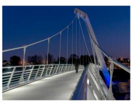
Main courante de la passerelle : 5630 Belval, 6 superwatts 0.8W blanc froid / Elliptique 2
