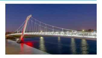
Pylône : 4040 Luminy 4, projecteur orientable à LED, ouverture  $10^{\circ}$ , 3x4 superwatts 3W : rouge/vert/bleu
