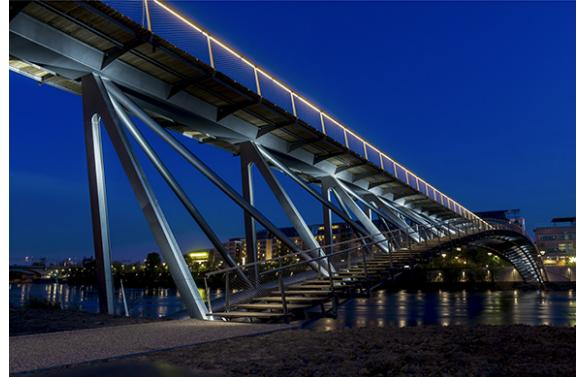
Pour la mise en lumière de l'arête de la structure métallique 54 projecteurs 4020-Luminy-2 en blanc froid 3 Superwatts 3W avec grille de défilement nid d'abeille viennent souligner chacune des barres métalliques. L'ensemble dimmable est piloté par des détecteurs de présence et controlé pour nuancer le rendu souhaité.
