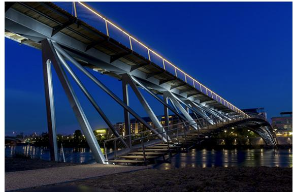
Pour la mise en lumière de l'arête de la structure métallique 54 projecteurs 4020-Luminy-2 en blanc froid 3 Superwatts 3W avec grille de défilement nid d'abeille viennent souligner chacune des barres métalliques. L'ensemble dimmable est piloté par des détecteurs de présence et controlé pour nuancer le rendu souhaité.
