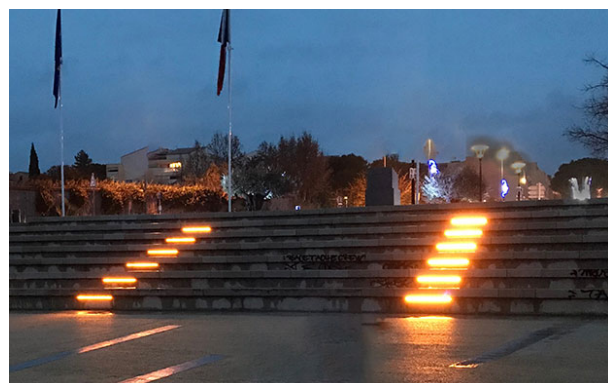
Les escaliers de la Rotonde du mail sont éclairés avec des barreaux Brunei de couleur ambre ref 5620 , encastrés dans les contre-marches des gradins.
