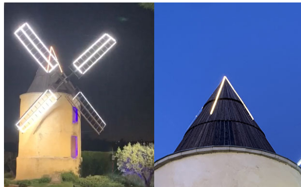
Surlignage de la toiture du moulin à l'aide de barreaux Lignon ref 5655
