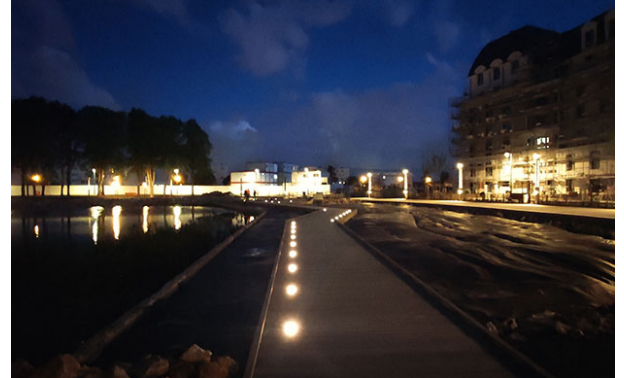
41 Chateauneuf ref 1570RLH-SF ont été installés dans le platelage bois
