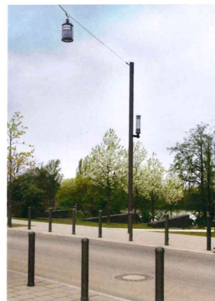
Abb.: Die Wege und Straßen im gesamten Areal werden mit zylindrischen LED-Leuchten erhellt. Über der Fahrbahn wurden sie abgependelt. Bei diesen Modellen nehmen 21 LEDs 37 W auf. Die Mastleuchten entlang der Fußwege integrieren 19 LEDs und haben eine Anschlussleistung von 19 W. (Fotos: Studio DL)
